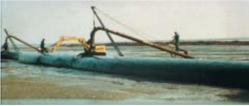
Un'altra opzione riguardo la mitigazione degli impatti delle mareggiate riguarda l'adozione di opere di difesa costiera tramite opere realizzate con materiali **geosintetici** i quali sono stati introdotti come soluzione specifica per la filtrazione/separazione e per la protezione nella realizzazione di interventi di difesa costiera.
